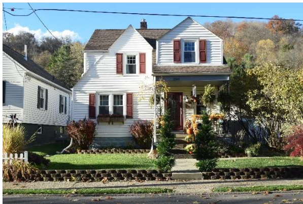
Fig. 41. 2369 Lumber Avenue (OH-1242), 2020.
