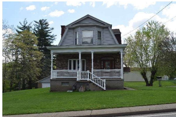
Fig. 27. 53 East Cove Avenue (OH-1362-0069), 2020.
